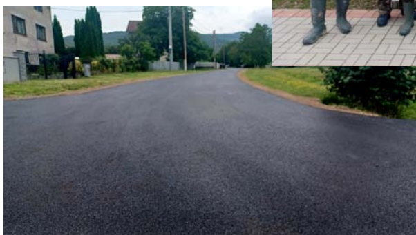
Oprava miestnej komunikácie
