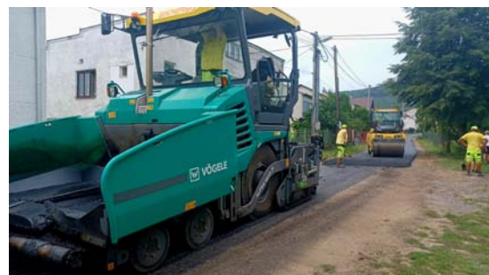
Oprava miestnej komunikácie
